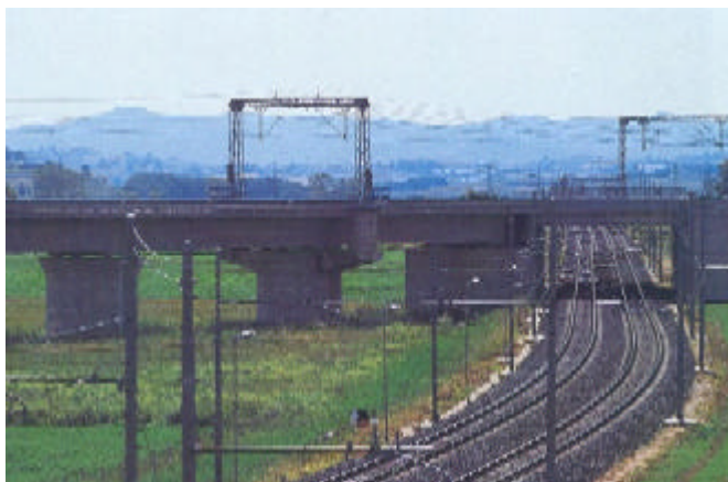
A sinistra: l'impiego dei particolari portali ha lo scopo di assorbire le sollecitazioni prodotte da velocità fino a 300 km/h
